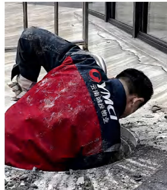
成都融城云熙项目，工程维修人员正在抢修停车场出口处的井盖，保障出行车辆和人员安全
