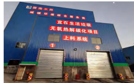
宜石生活垃圾无氧热解碳化项目
